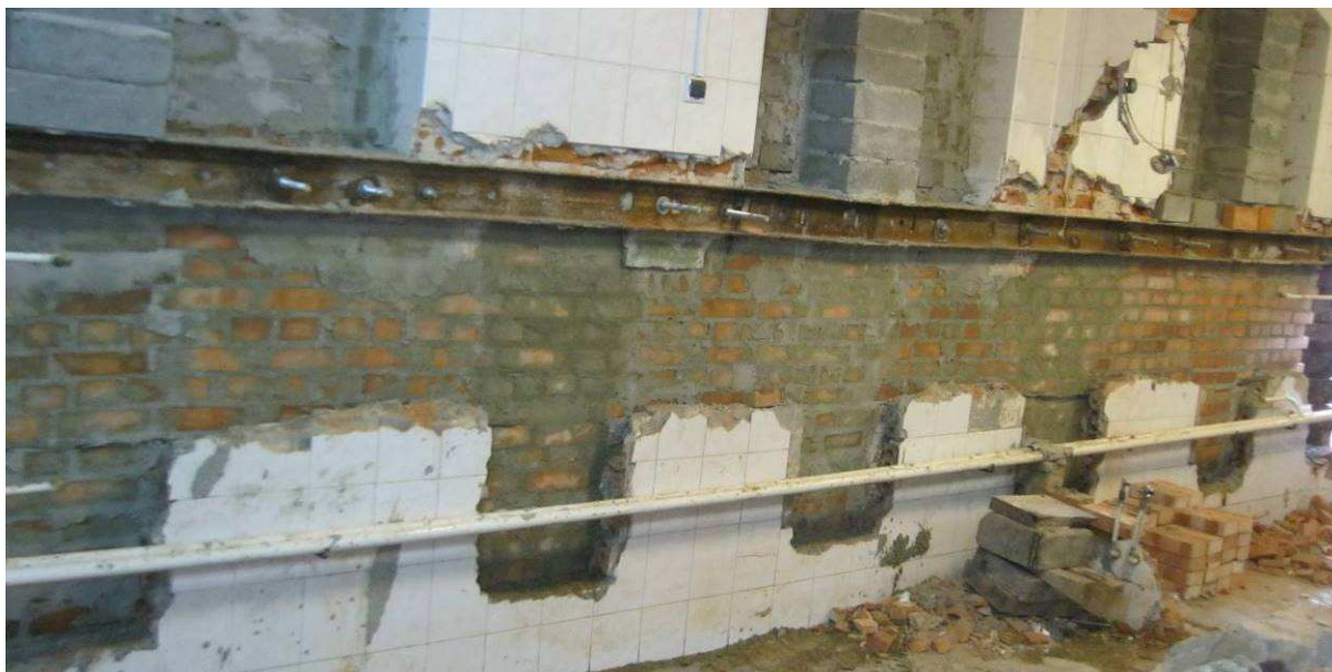
Fot. 6 Zamurowanie szczeliny i otworów po siłownikach
