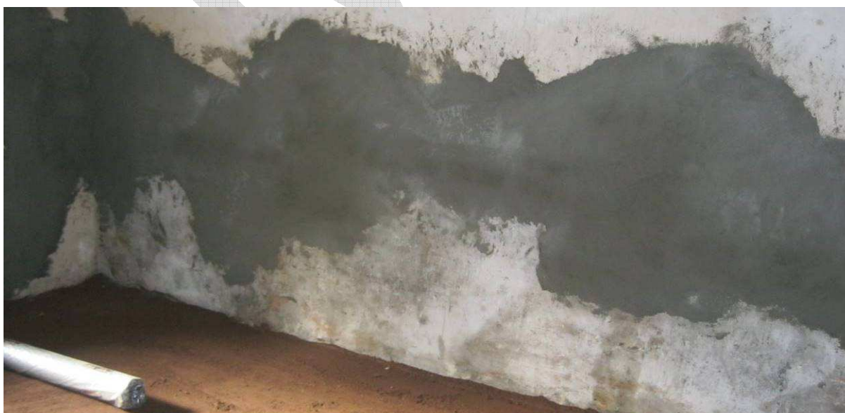
Fot. 7 Uzupelnienie tynków na ścianie w miejscu zamurowania szczeliny po prostowaniu
