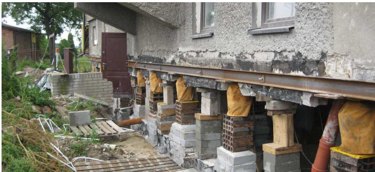
Fot. 4 Budynek w trakcie prostowania
