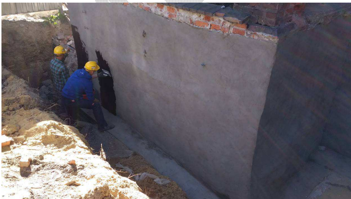
Fot. 12 Wykonywanie pionowej hydroizolacji bitumicznej na ścianach piwnic
