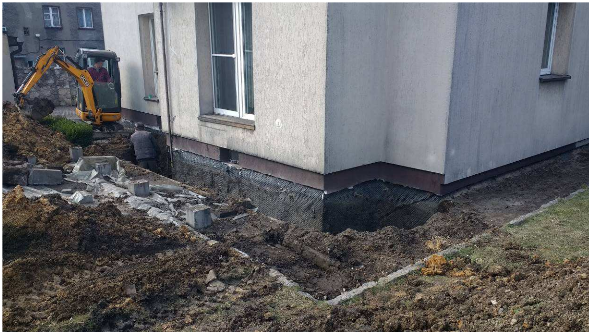
Fot. 1 Odkopanie ścian piwnicznych budynku
