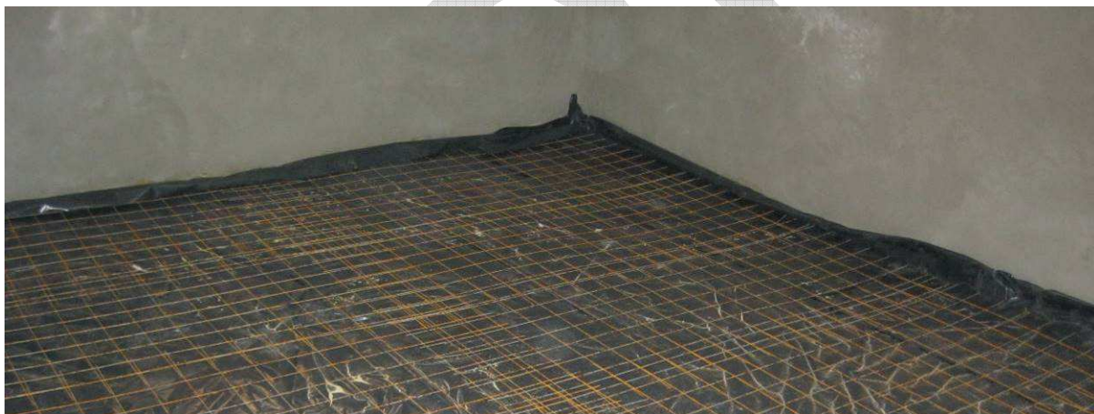
Fot. 9 Siatka zbrojeniowa do posadzki, ułożona na warstwie hydroizolacyjnej
