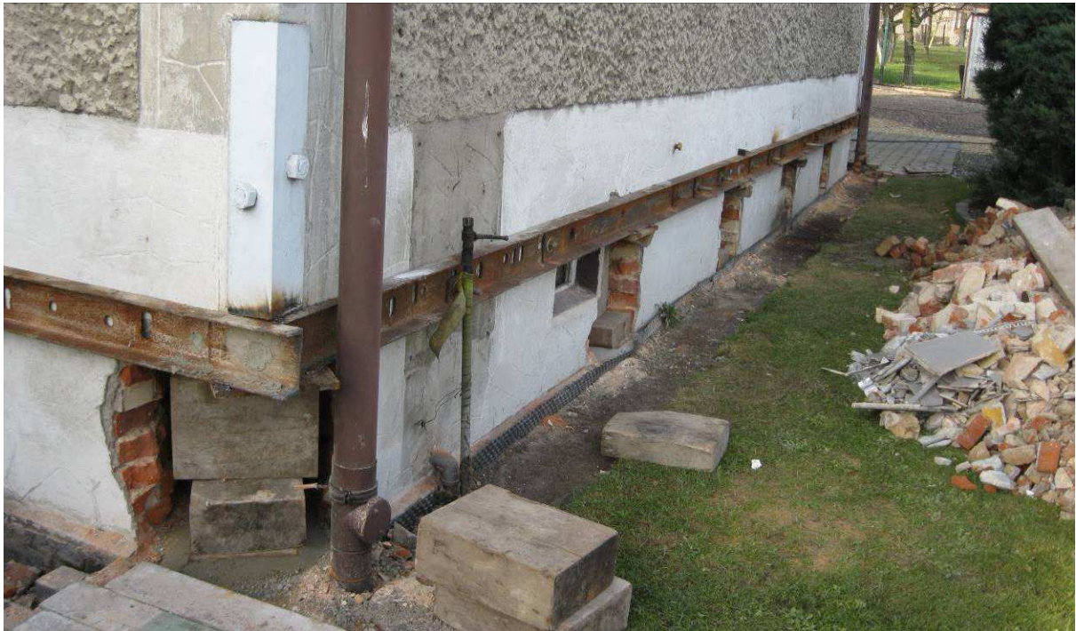
Fot. 3 Konstrukcja stalowa na ścianach budynku
