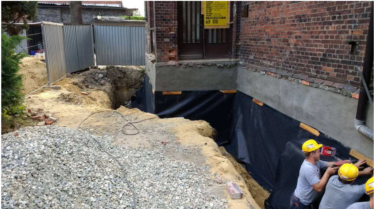
Fot. 13 Wykonywanie warstwy hydroizolacji ścian piwnicznych z folii kubelkowej
