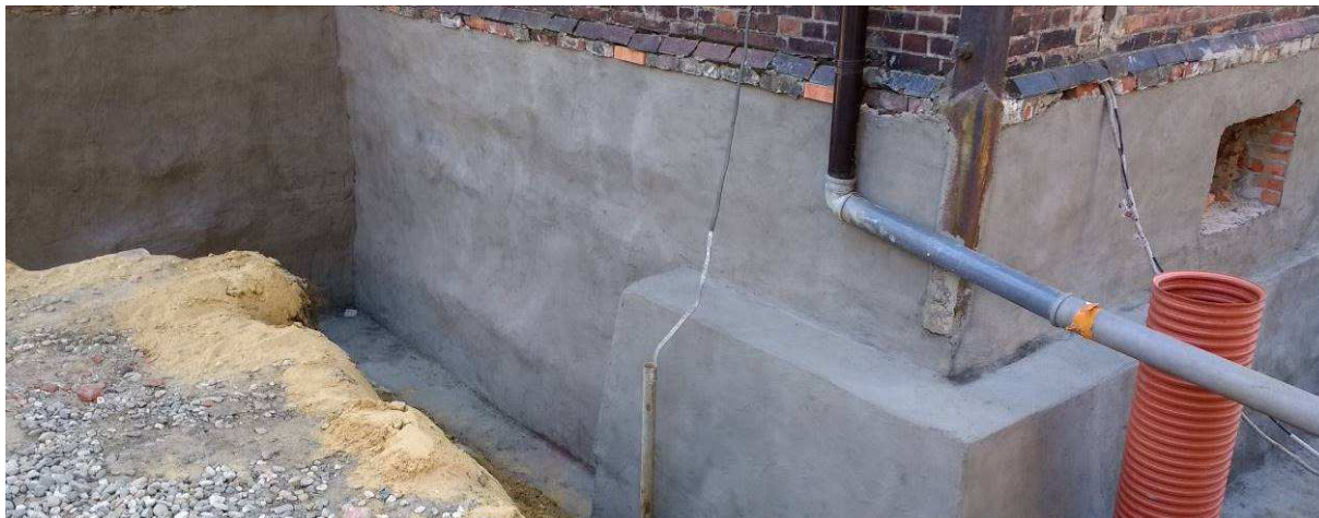
Fot. 11 Tynk zewnętrzny na ścianach piwnicznych
