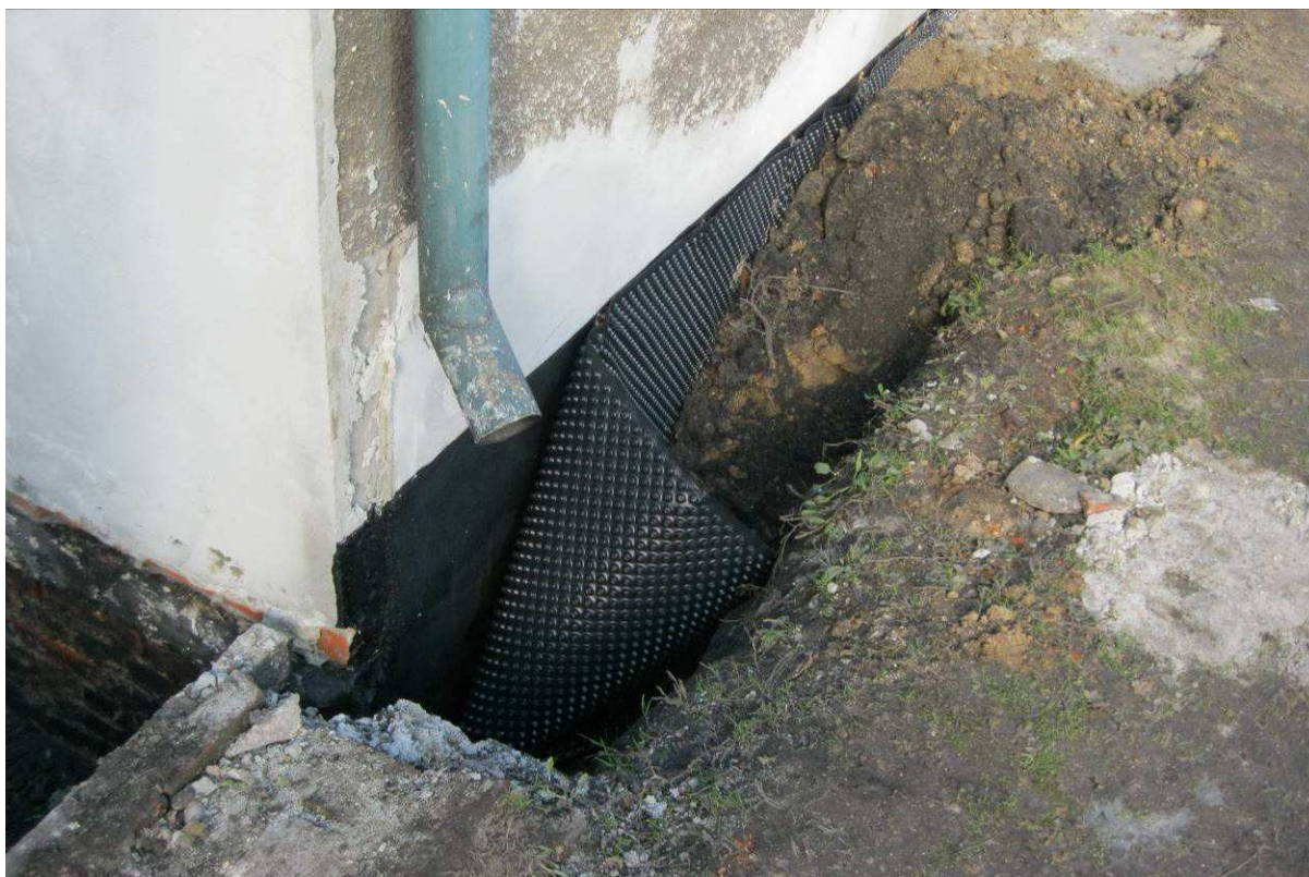
Fot. 15 Etapowe zasypanie wykopów z zagęszczaniem warstwami
