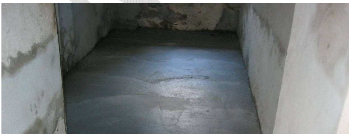
Fot. 10 Nowa posadzka wykonana w kondygnacji prowadzenia prac rektyfikacyjnych
