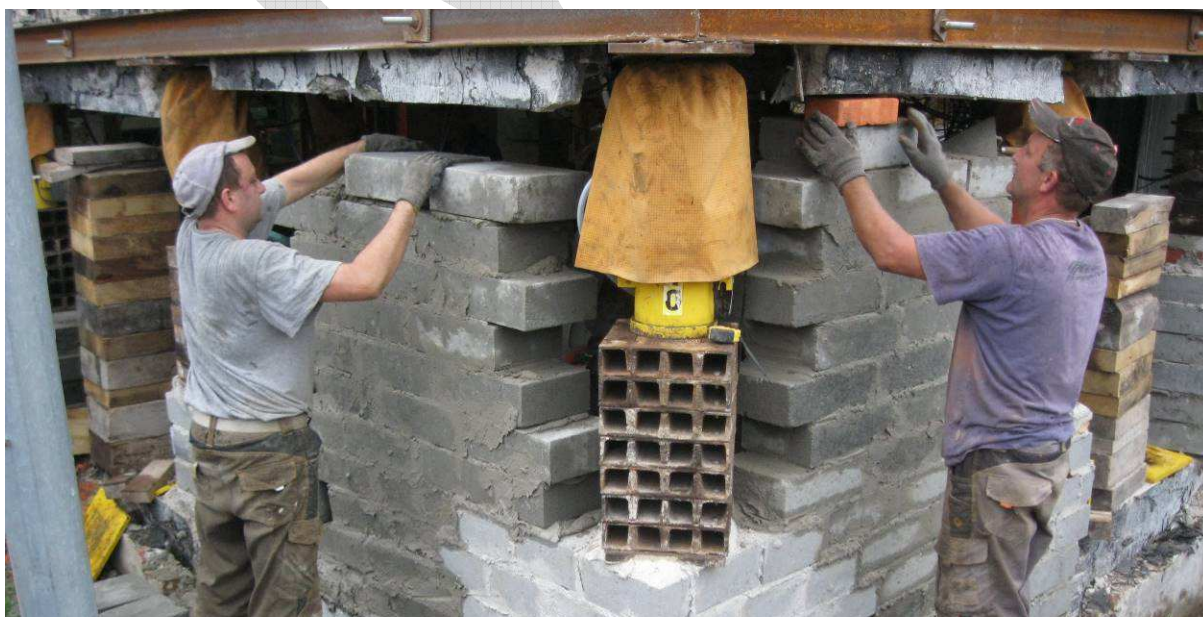
Fot. 5 Uzupełnienie szczeliny w ścianach powstałej na skutek prostowania - murowanie przestrzeni między siłownikami
